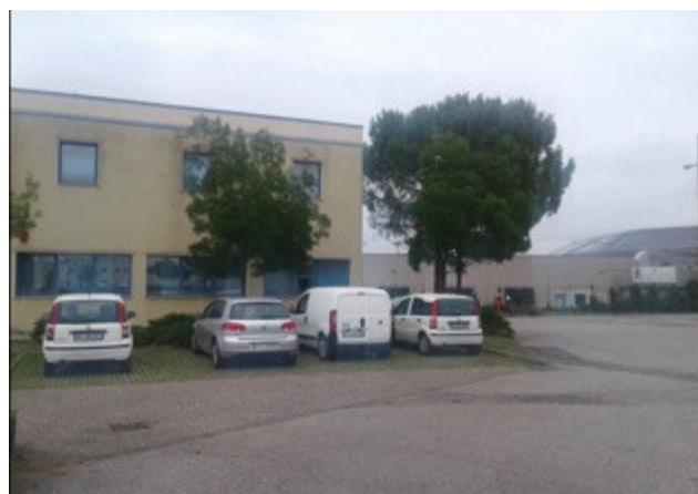
Foto: palazzina uffici e spogliatoi
