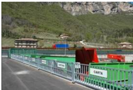
Foto: Area verde (area stoccaggio rifiuti)
