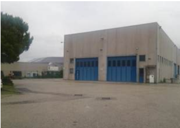
Foto: capannone magazzino ed autorimessa e officina in affitto
