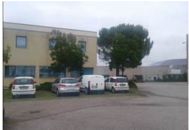
Foto: palazzina uffici e spogliatoi
